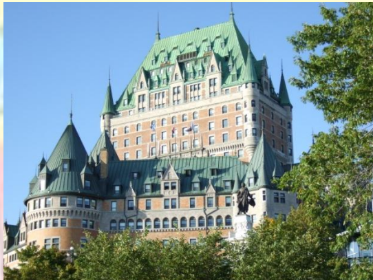
das Château Frontenac
